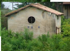
Stazione di Caprarola e particolare magazzino merci
