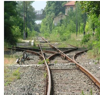
Stazione di Ronciglione – particolare scambi
