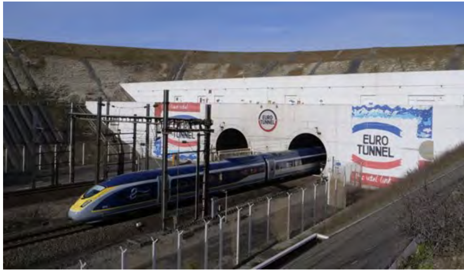
Figura 5-49 Channel Tunnel – Imbocco gallerie lato Francia
