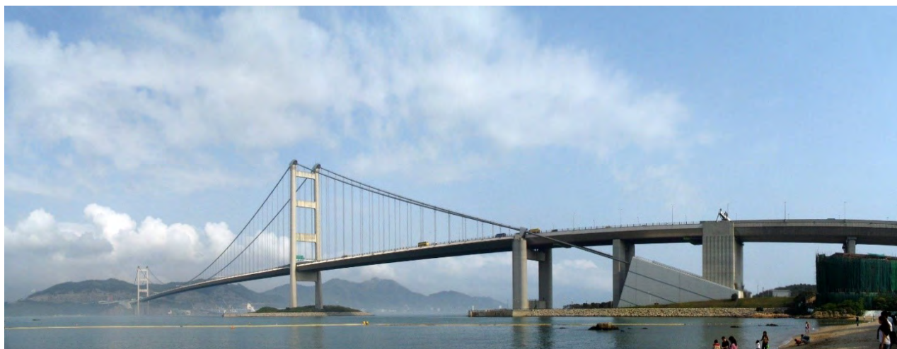
Figura 5-17 Tsing Ma Bridge visto dalla penisola Ma Wan 131
