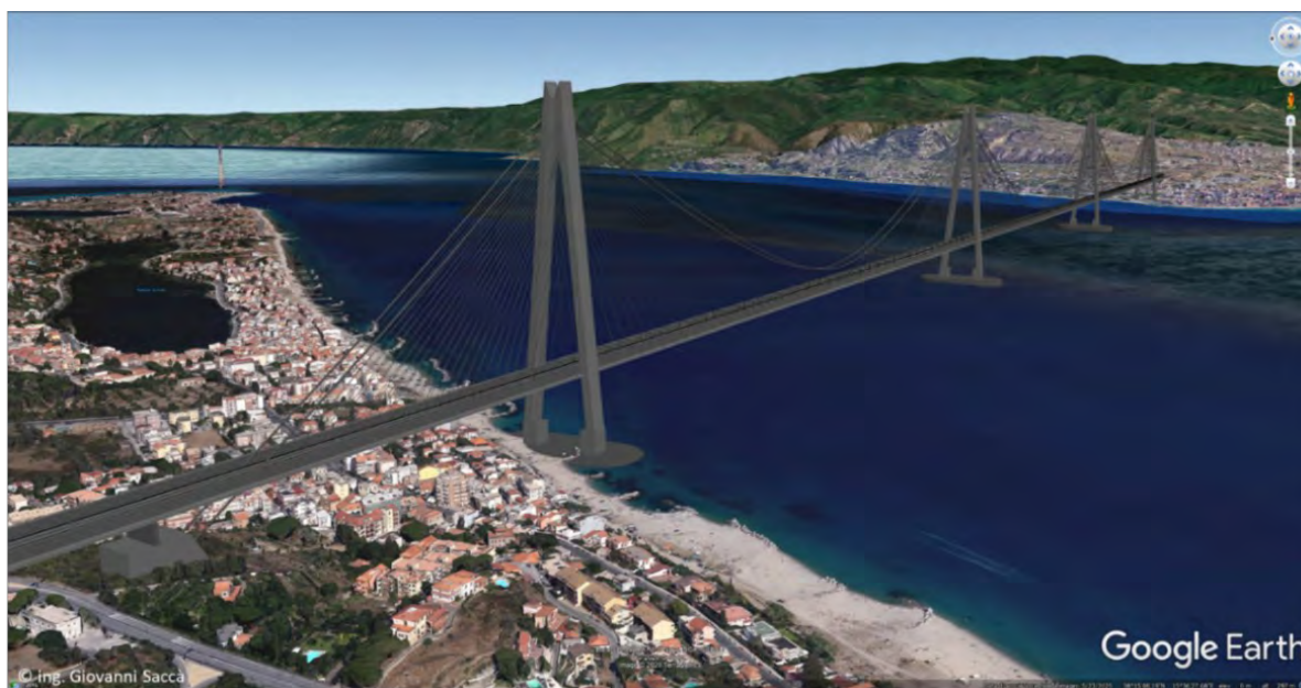
Figura 7-7 Ponte strallato a tre campate – Vista da Messina
