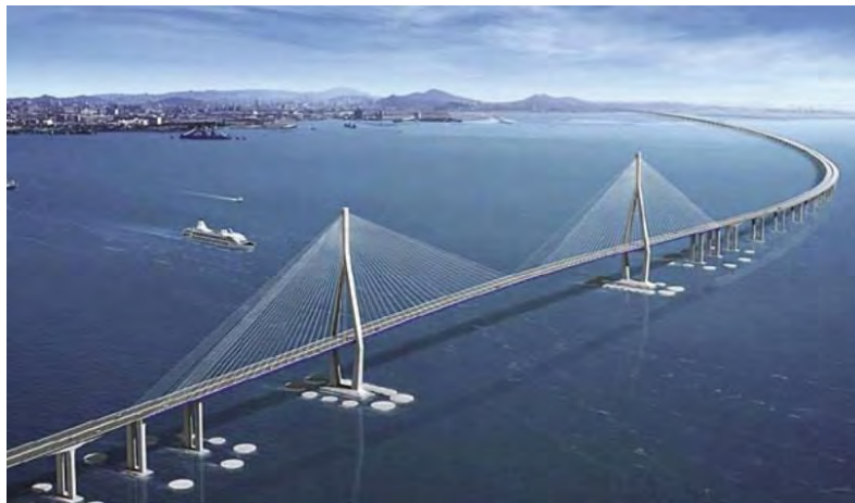
Figura 5-29 Esempio di sistema di protezione da collisioni navali: “2nd Incheon Bridge, Korea” Fonte: COWI A/S
