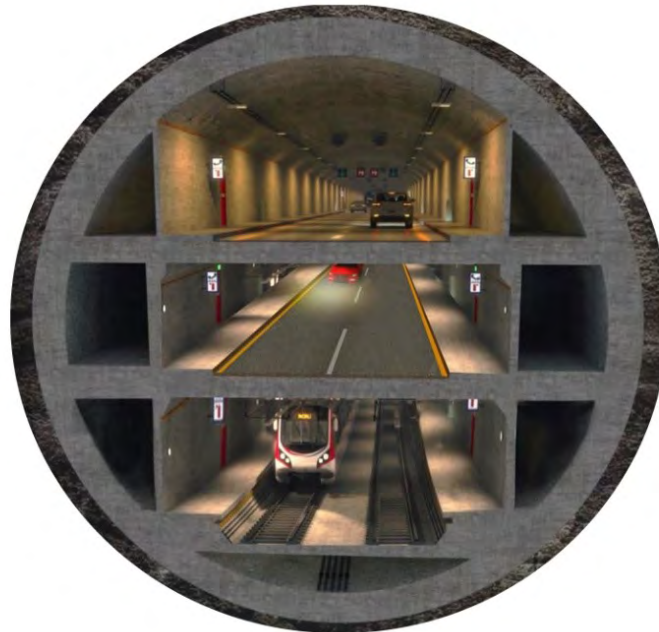
Figura 5-46 Grande Tunnel di Istanbul – sezione trasversale
