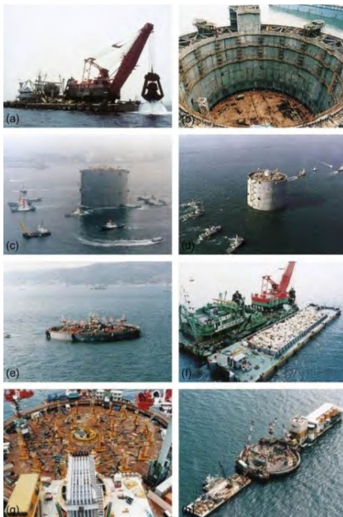
Figura 5-32 Fasi di realizzazione delle fondazioni dell'Akashi-Kaikyo Bridge 154
