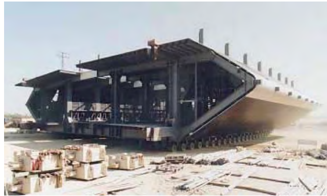
Figura 7-12 Ponte Tsing Ma – Concio di impalcato
