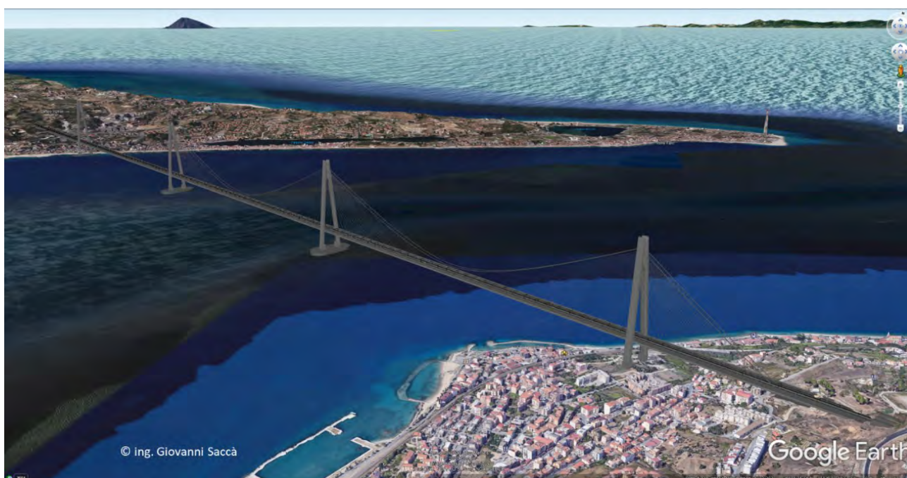
Figura 7-6 Ponte a tre campate– Vista da Villa San Giovanni
