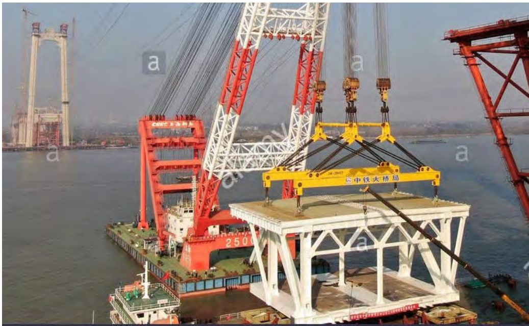
Figura 5-23 Elemento modulare di impalcato del Wufengshan Yangtze River Bridge durante la fase di costruzione 140
