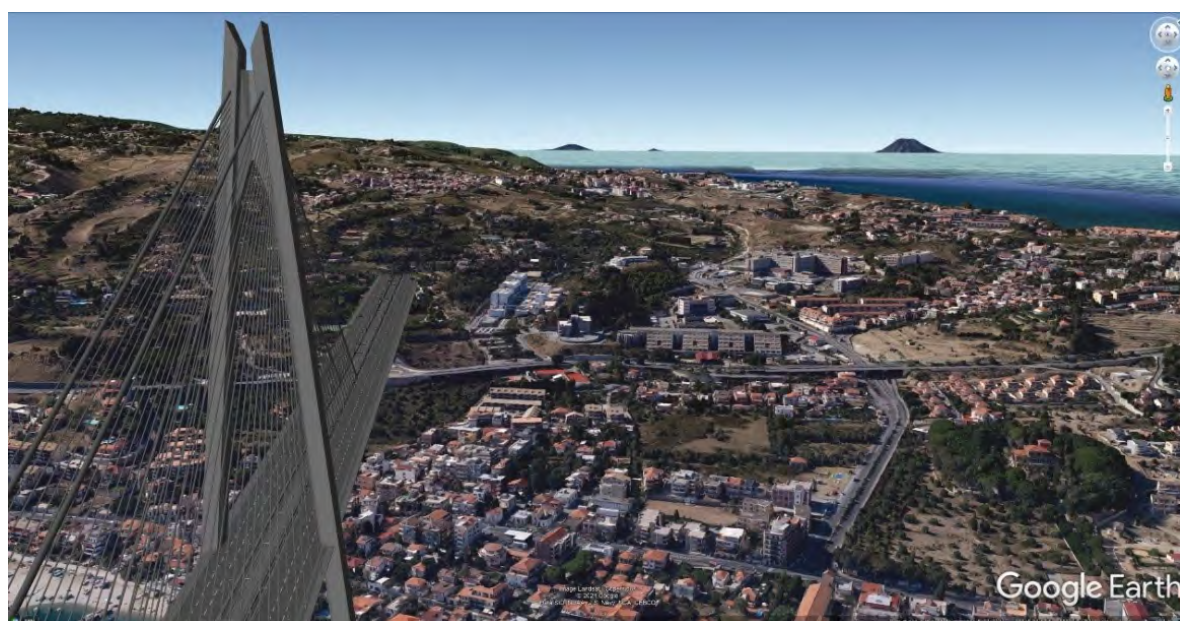
Figura 7-8 Ponte a tre campate – Vista estremità lato Sicilia
