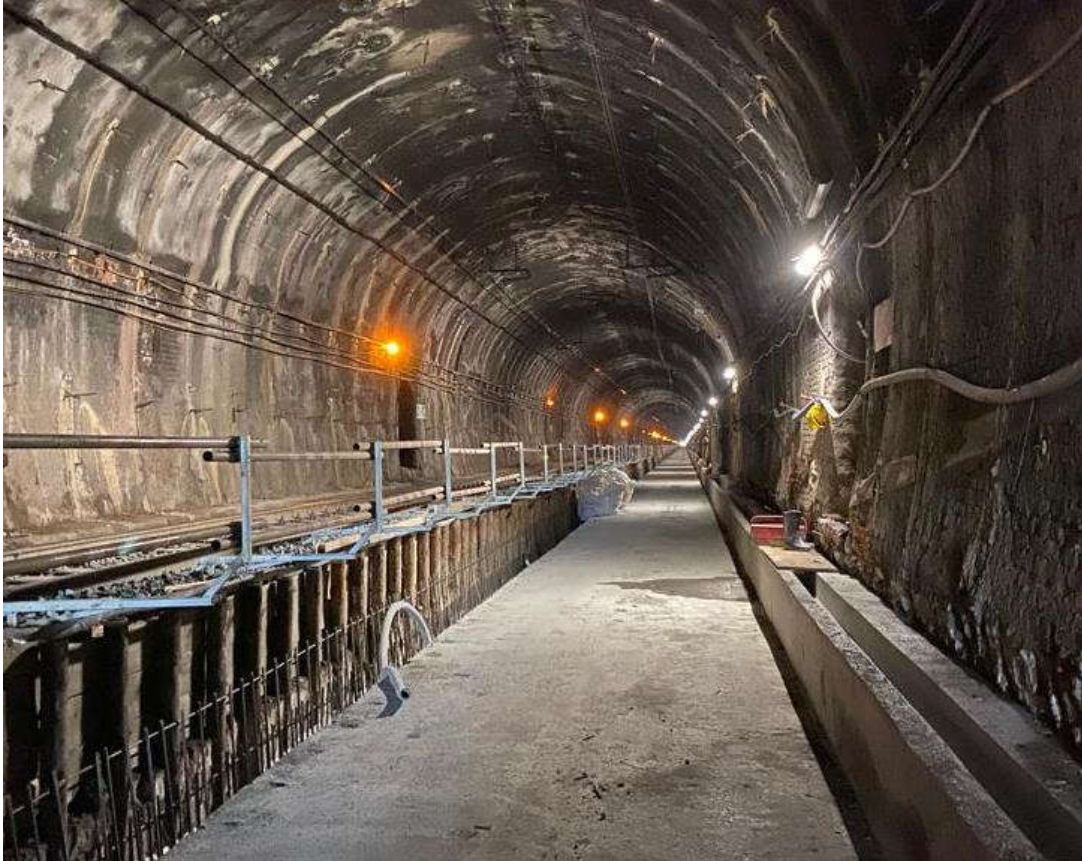
Avvisatori ottico-sonori del sistema ATWS in azione
