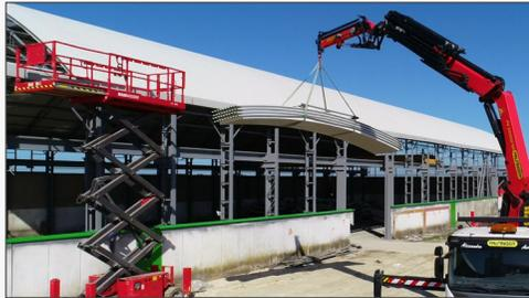
SOSTITUZIONE COPERTURE E TAMPONATURE
