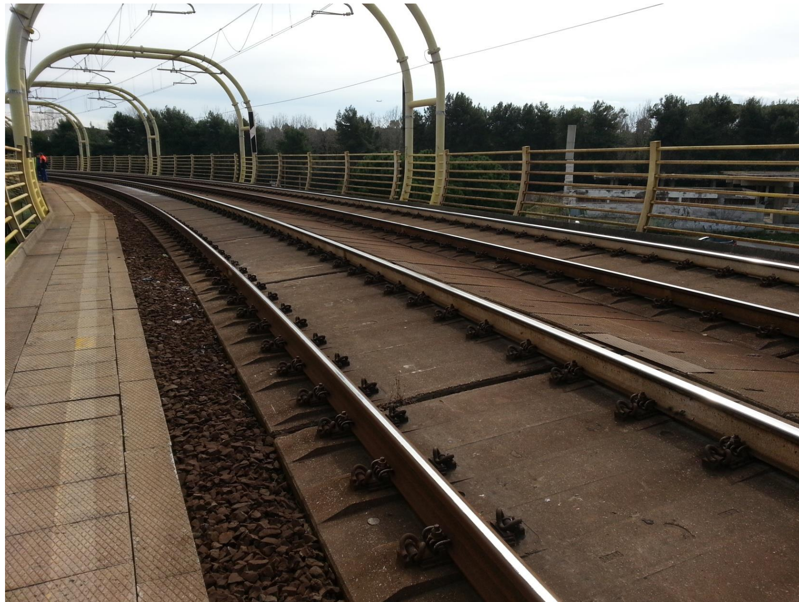
Roma Fiumicino Viadotto di approccio alla stazione
