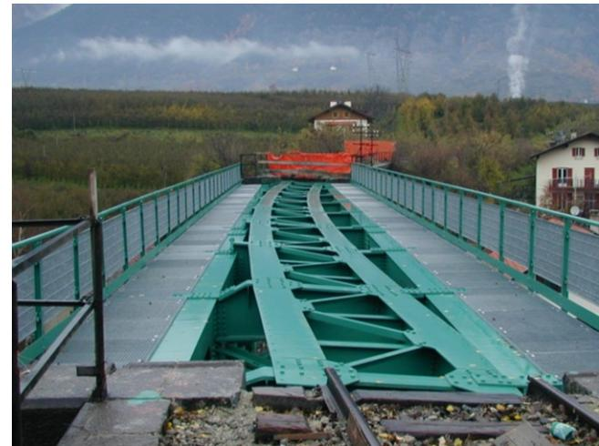
Il binario è stato realizzato con la lunga rotaia saldata, avvalendosi, per la prima volta in Italia, di traversine in acciaio ad “Y” per consentire la continuità del binario anche in presenza di raggi di curvatura assai stretti.
