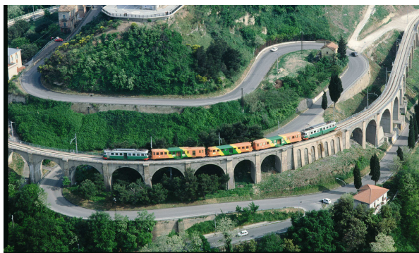
“Il Treno Della Valle” in transito sul ponte elicoidale di San Vito Marina
