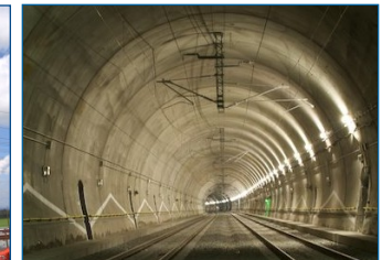
Sicurezza in galleria
