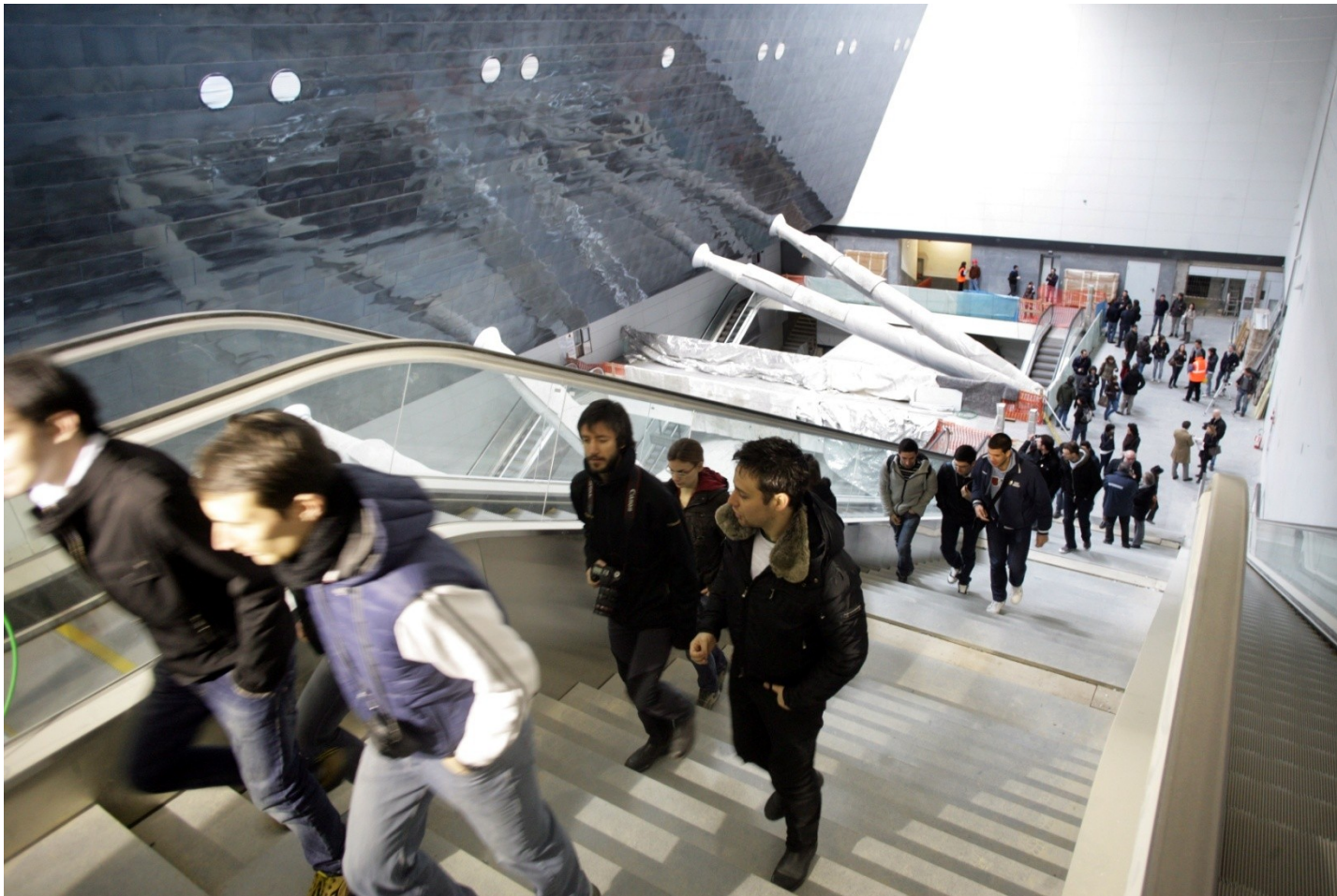
Metro Brescia – stazione tipo profonda
