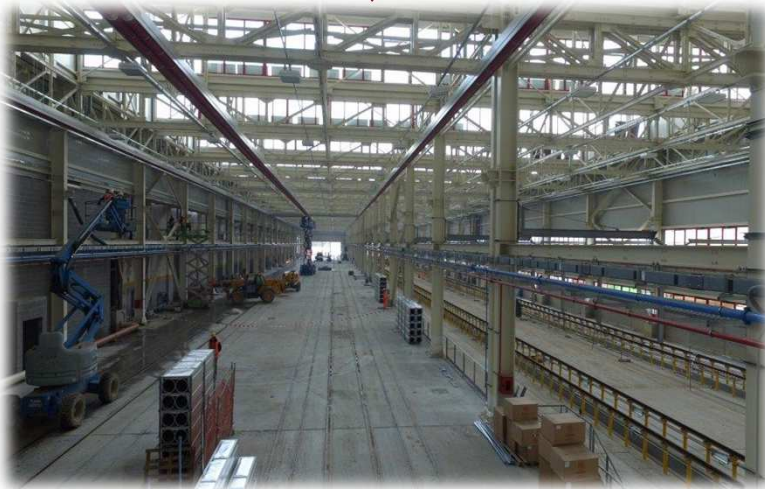
Riscaldamento Tubi Radianti
