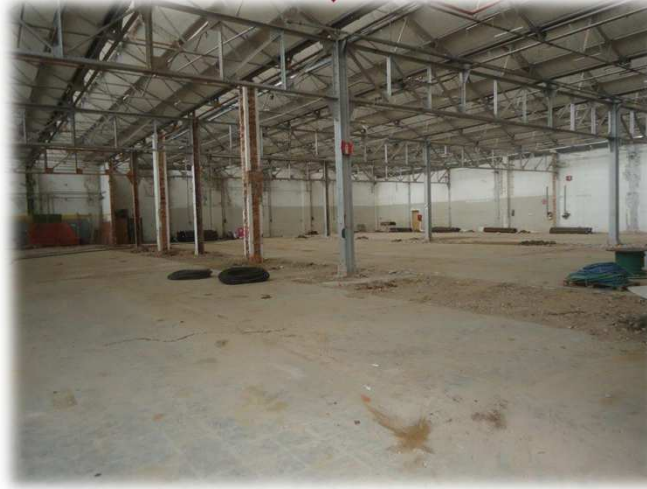
Ampliamento Reparto Carrelli
