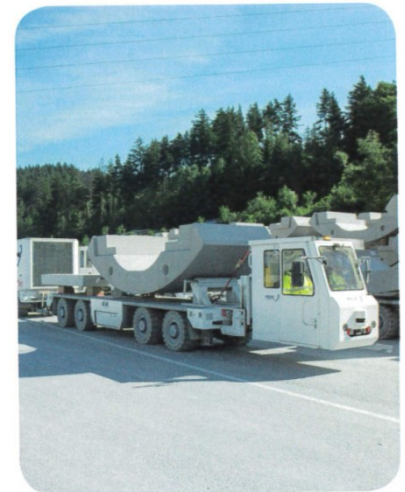
L'approvvigionamento della fresa nel cunicolo esplorativo di Ahrental-Pfons viene svolto dal così detto „Multi Service Vehicle“.
