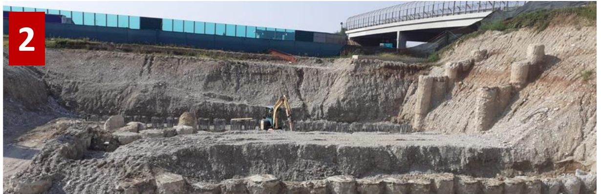
Galleria Lonato - Imbocco Ovest
