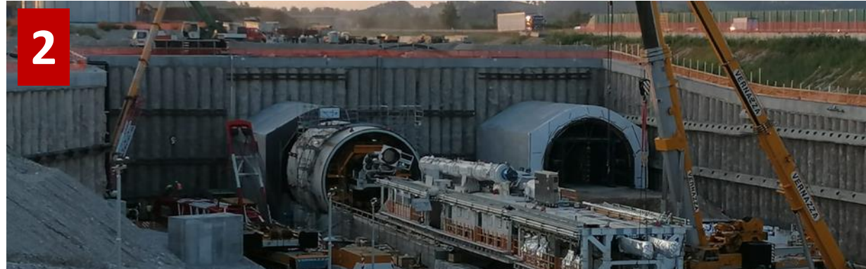
Galleria Lonato - Imbocco Ovest
