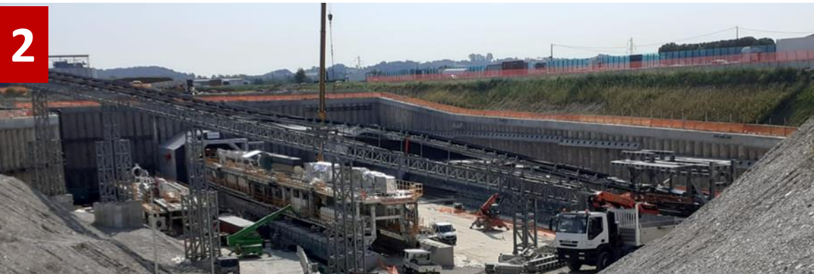
Galleria Lonato - Imbocco Ovest
