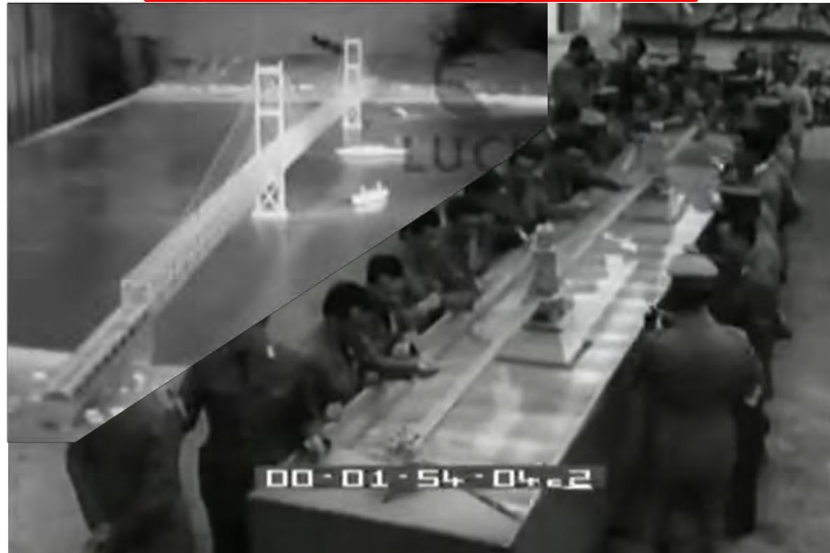
Il **Progetto Steinmann (1952)**, prevedeva la costruzione di due torri alte 220 m sopra il livello dell'acqua con fondazioni realizzate in acque profonde circa 120 m.
