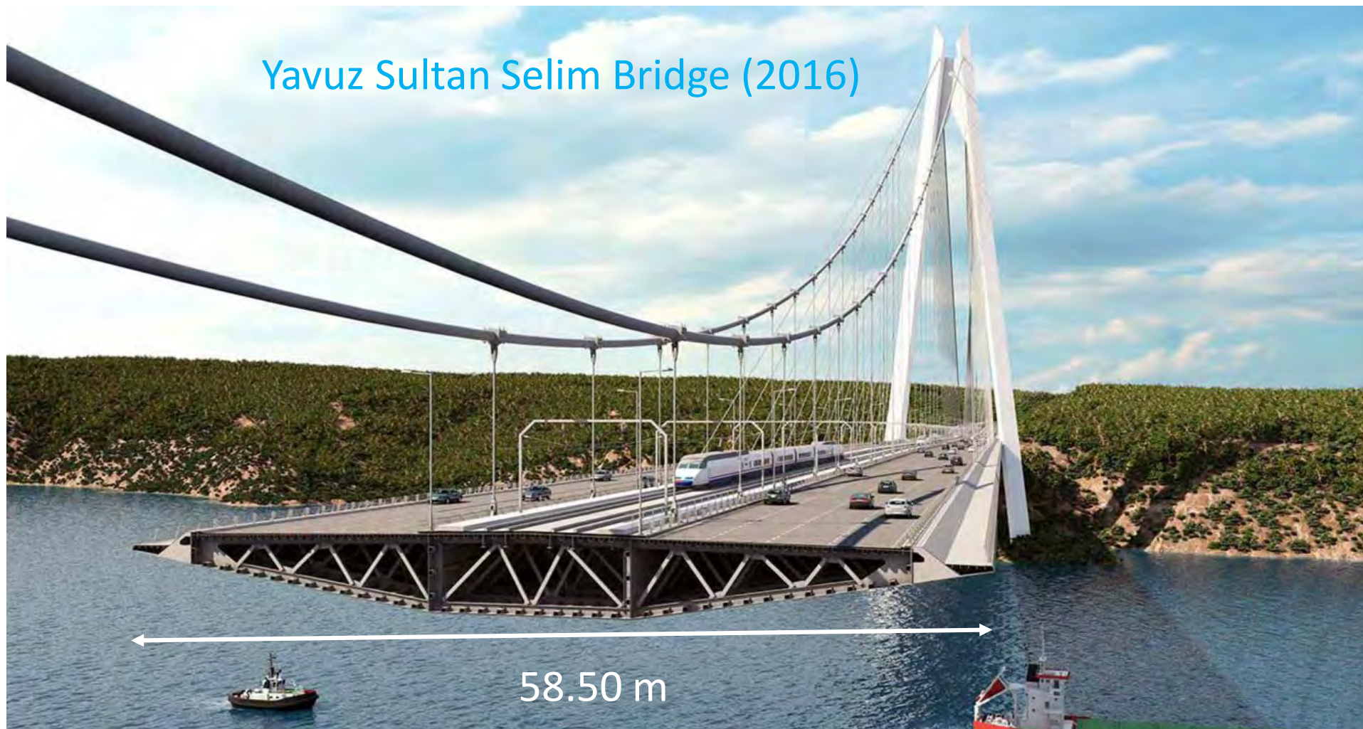
Yavuz Sultan Selim Bridge (2016) Sezione trasversale
