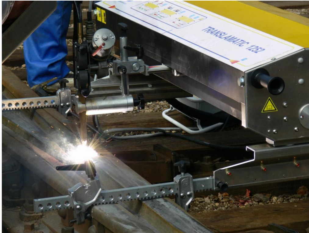
Braccio automatizzato «Traslamatic» in fase di saldatura
