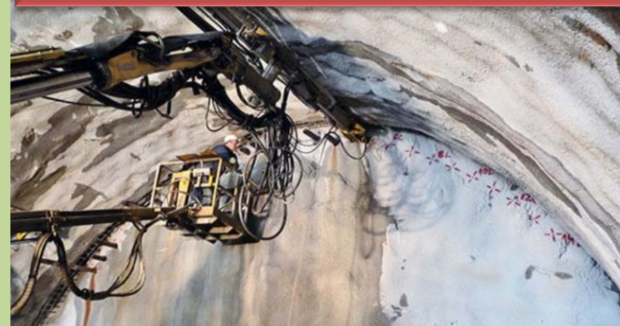
ESECUZIONE INFILAGGI DI VOLTA
