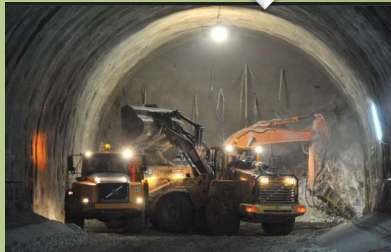
4 COMPLETAMENTO RIMOZIONE DELLO SMARINO
