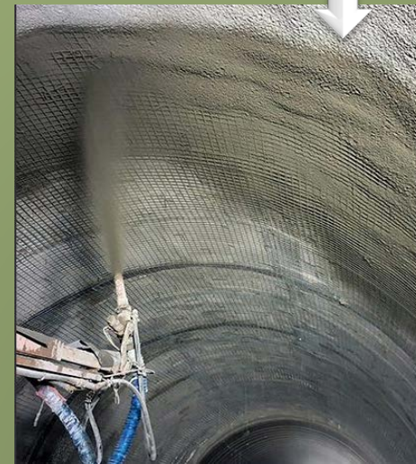
6 SOSTEGNO MEDIANTE CALCESTRUZZO PROIETTATO
