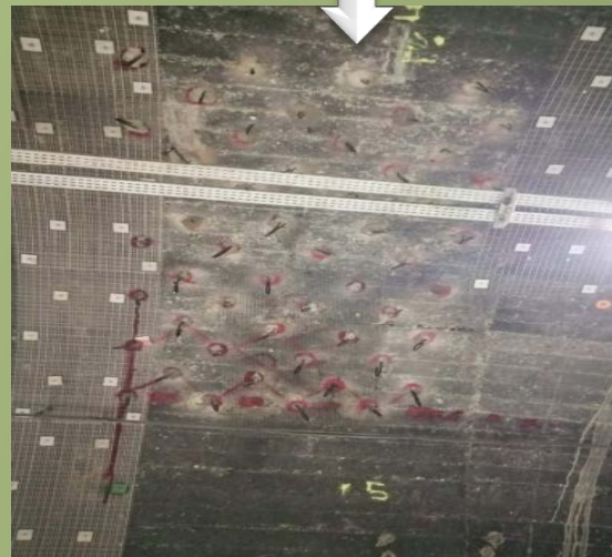
5 SOSTEGNO MEDIANTE BULLONI
