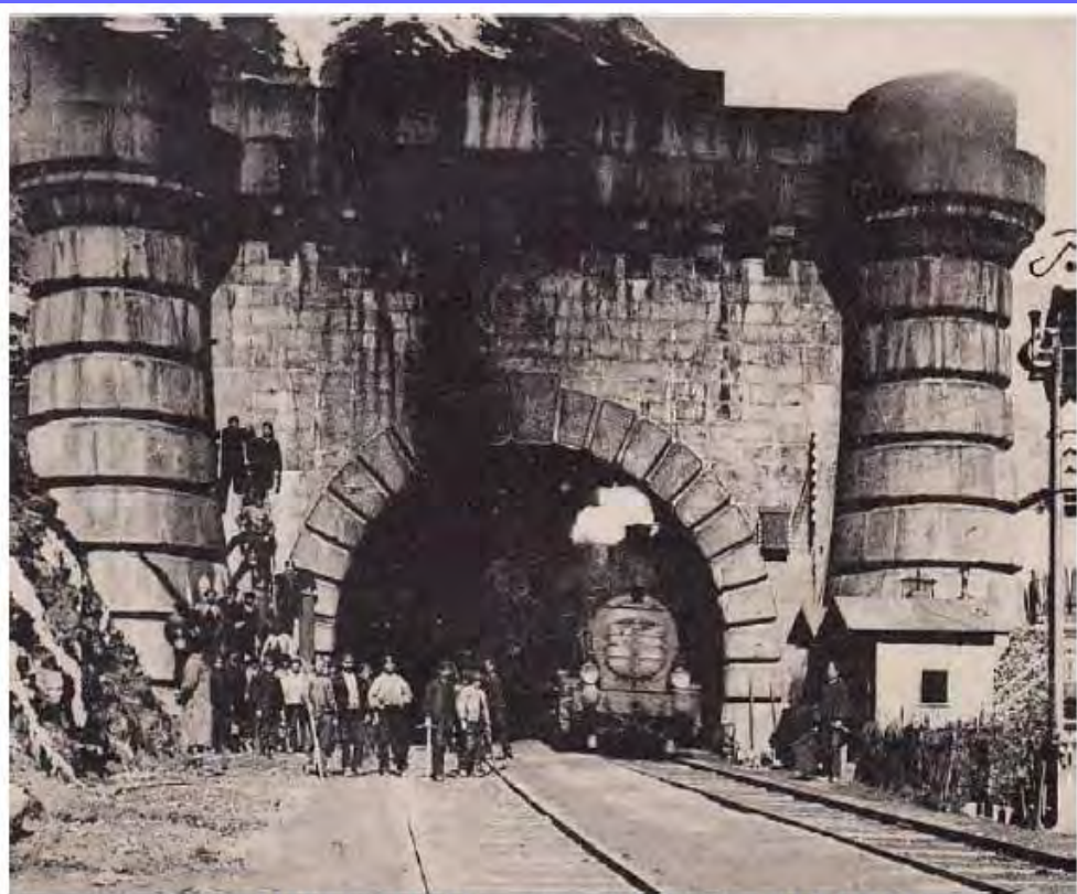
Figure 3- Portail italien du tunnel du Fréjus en 1871 / Portale italiano del tunnel del Frejus nel 1871
