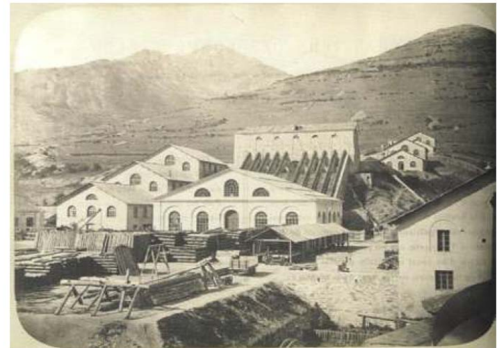
La struttura che ospitava i compressori dal lato italiano alimentati da dieci condotte forzate
