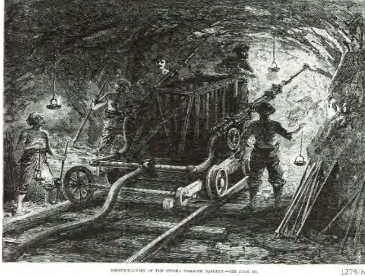
L'avvio della perforazione meccanica dei fori da mina (Collezione GILIBERT)
