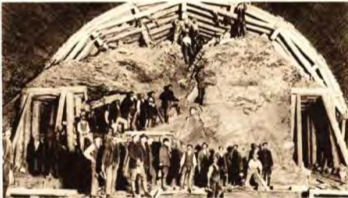
Armatura della calotta e scavo dei pié dritti
