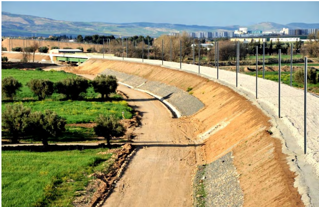
Rilevato pk 55+300 con protezione in materassi reno
