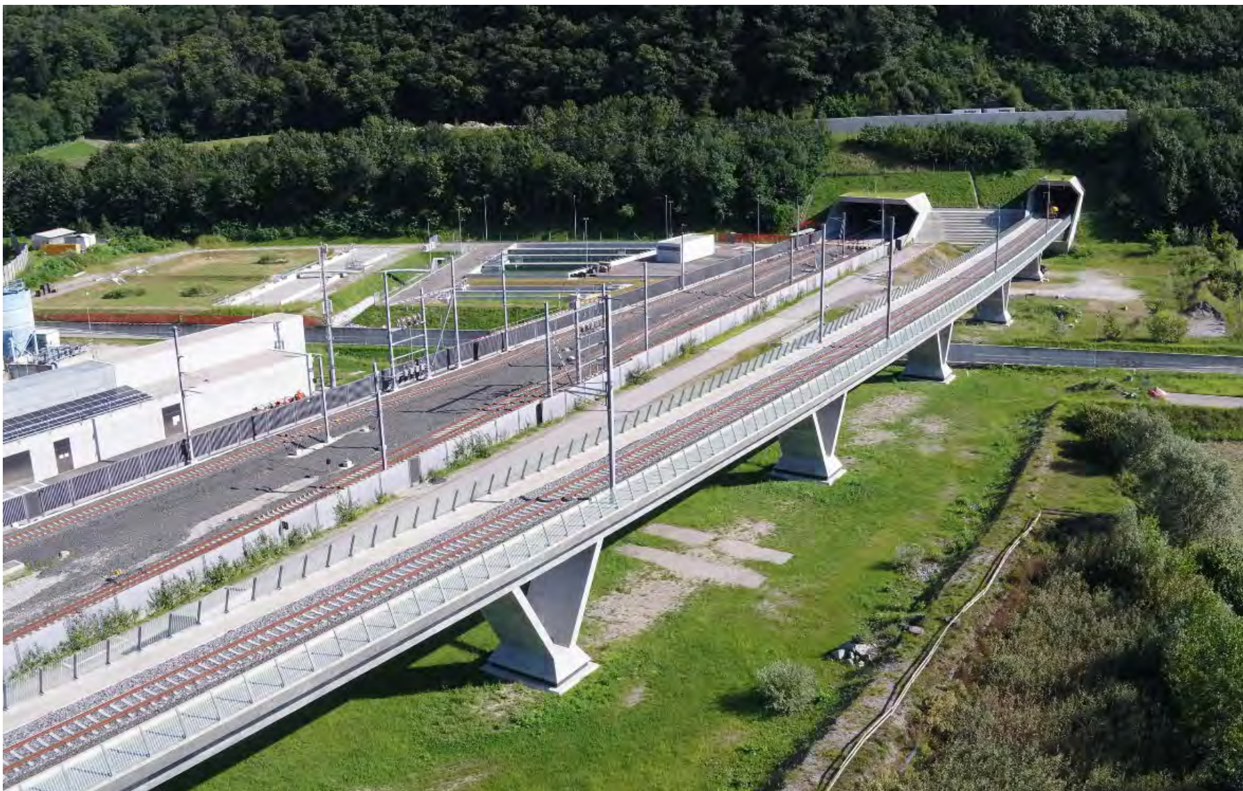
Vista verso sud (Portale nord GbC)
