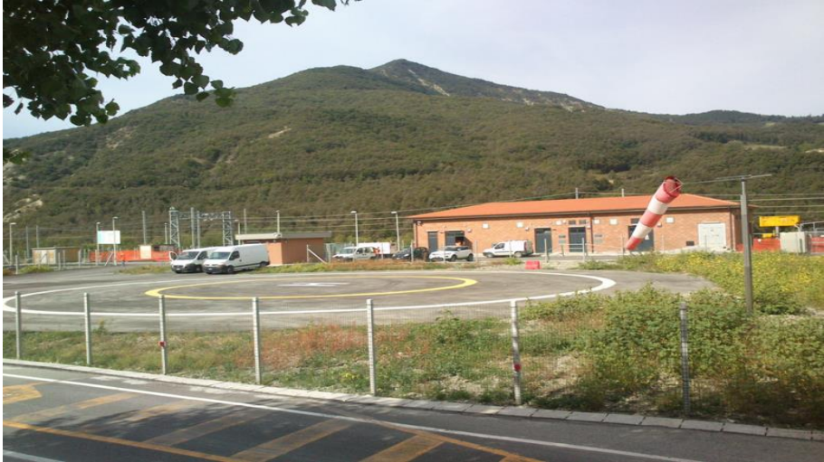
Fabbricato tecnologico ed elisuperficie
