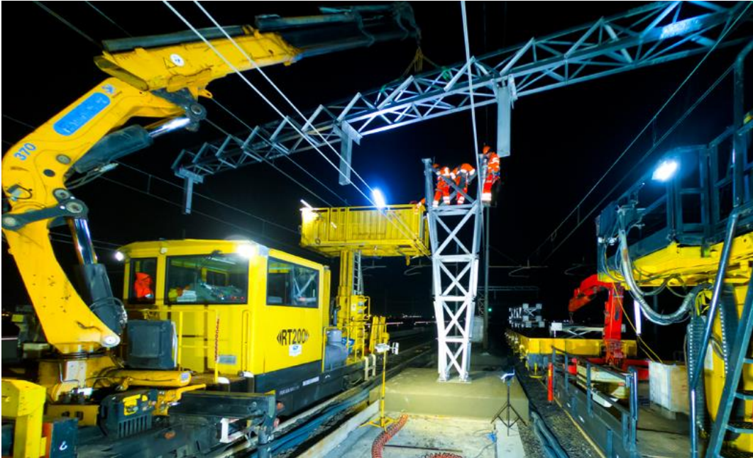
☆ Posa della trave
