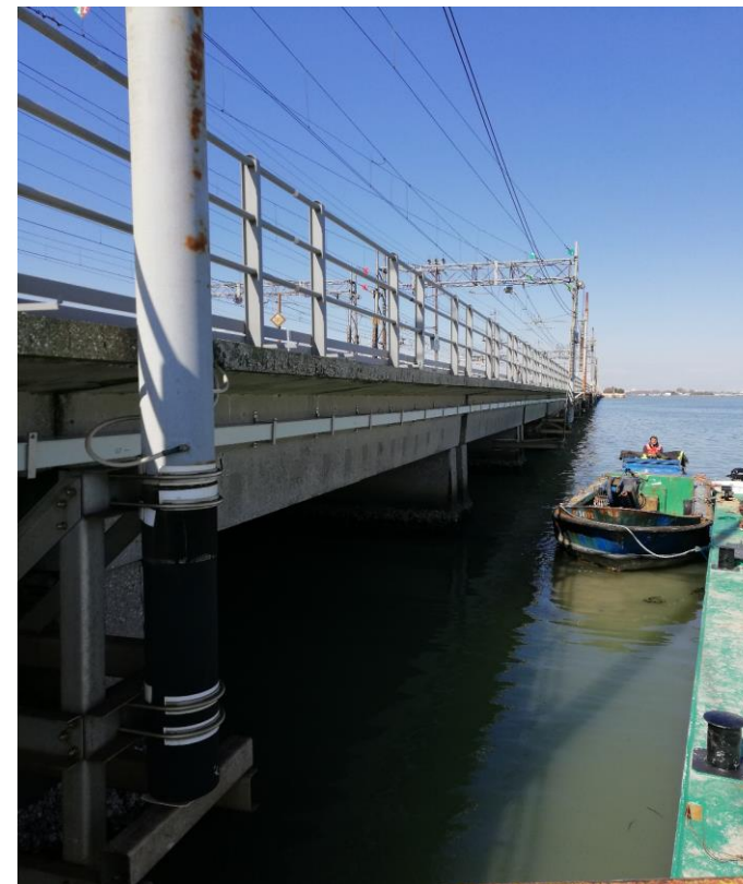
★ Canaletta lato Ponte nuovo
