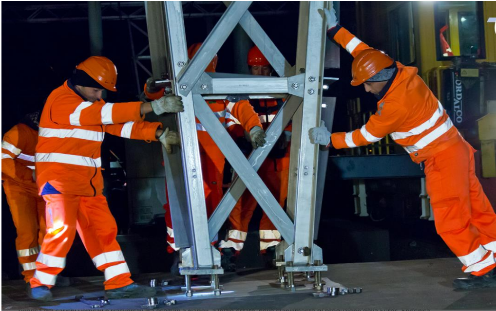
☆ Posa del pedritto reticolare
