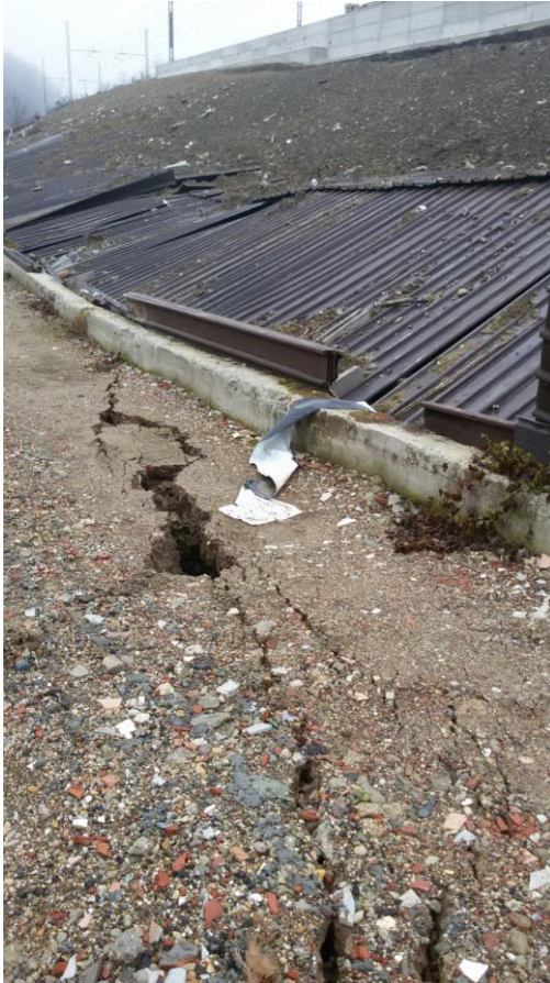
Formazione tension crack lungo la scarpata, disarticolazione e traslazione verso valle portale d'imbocco del cunicolo
