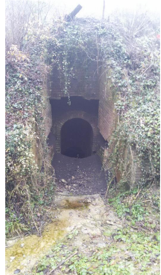
Formazione tension crack lungo la scarpata, disarticolazione e traslazione verso valle portale d'imbocco del cunicolo
