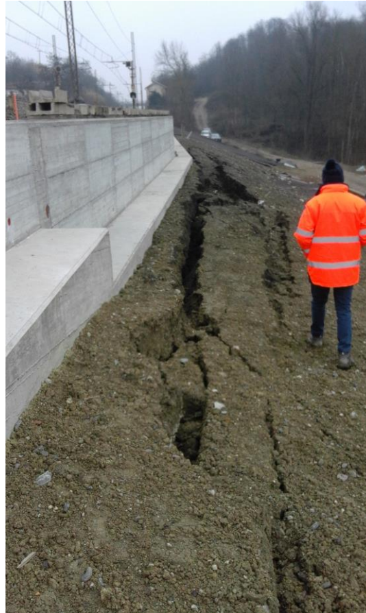
Formazione tension crack lungo la scarpata, disarticolazione e traslazione verso valle portale d'imbocco del cunicolo
