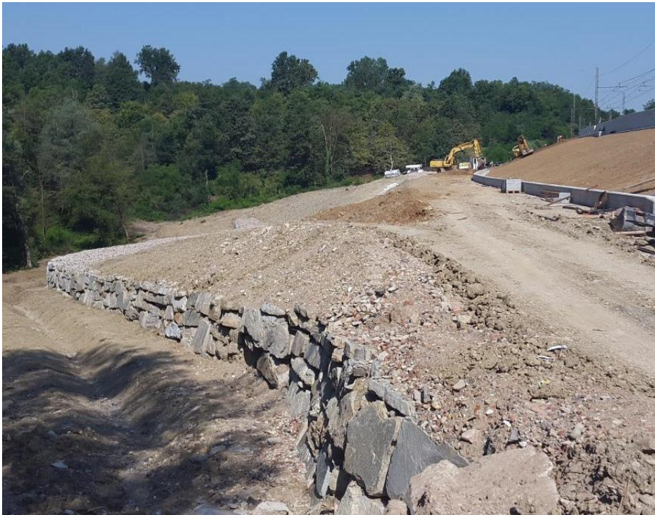
Scogliera in massi al piede del rilevato
