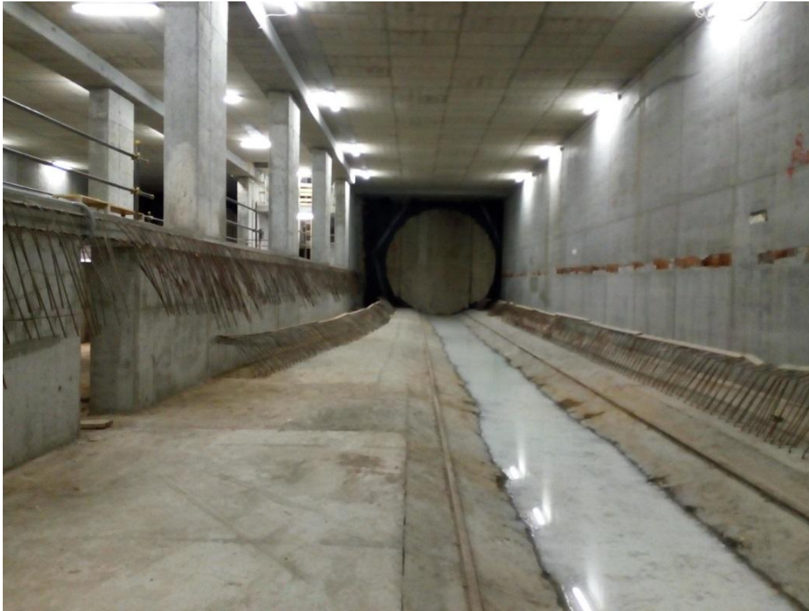
Banchina binario dispari – area di traslazione TBM
