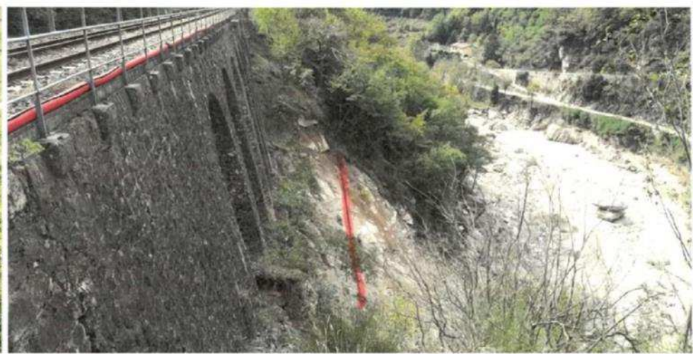
Foto prima dei lavori novembre 2020
