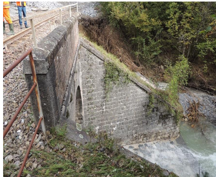
Erosione del rilevato di approccio al ponte al km 42+577 sul Rio Maschetta
