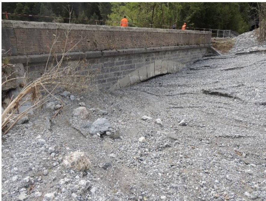
Ponte al km 42+512 sul rio Dente (tra la stazione di Vievola e Tende): deposito di materiale alluvionale
