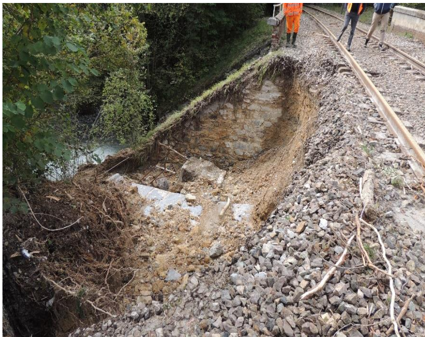
Erosione del rilevato di approccio al ponte al km 42+577 sul Rio Maschetta
