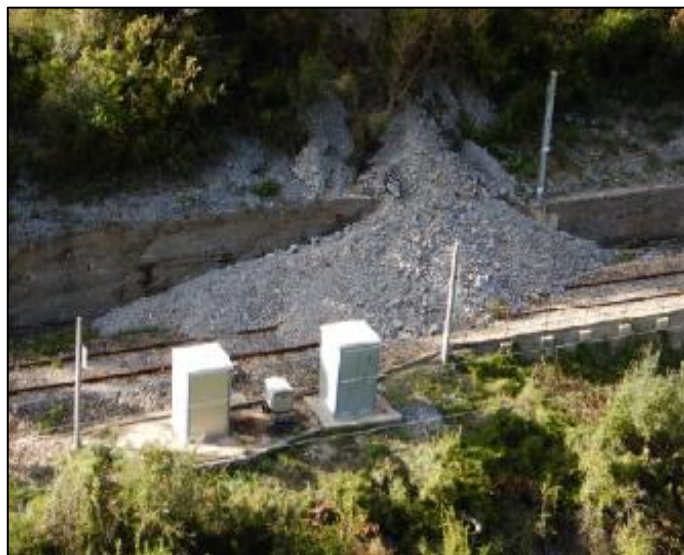
Frana che ha interessato un tratto di linea compreso tra le stazioni di Breil e di Fontan Saorge
