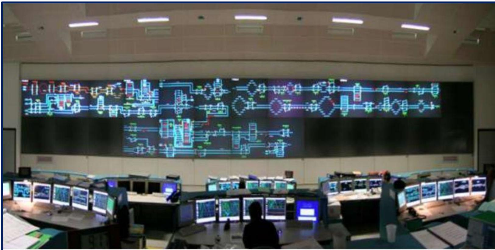
SCC/M (SCC per ACCM) è il più avanzato sistema di Supervisione e Regolazione atto a interfacciarsi con gli Apparati Centrali a Calcolatore Multistazione e conserva la possibilità di gestire impianti di generazioni precedenti (ACEI, ACC) ed integra funzionalità per la gestione automatica di grandi stazioni
