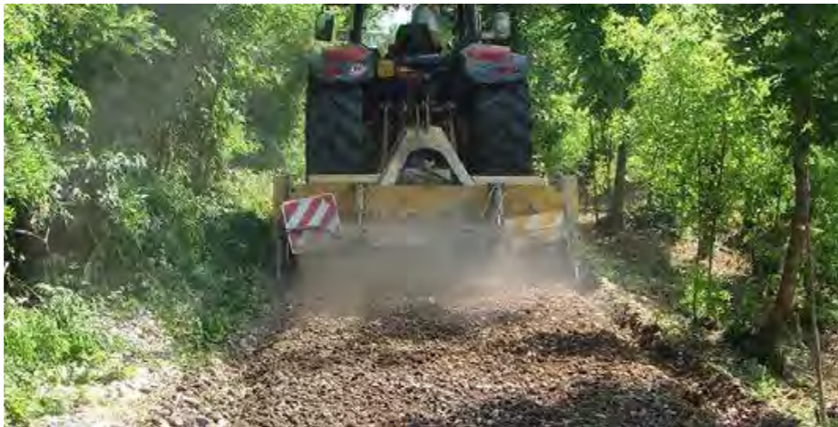
3. Operazioni di frantumazione del ballast
