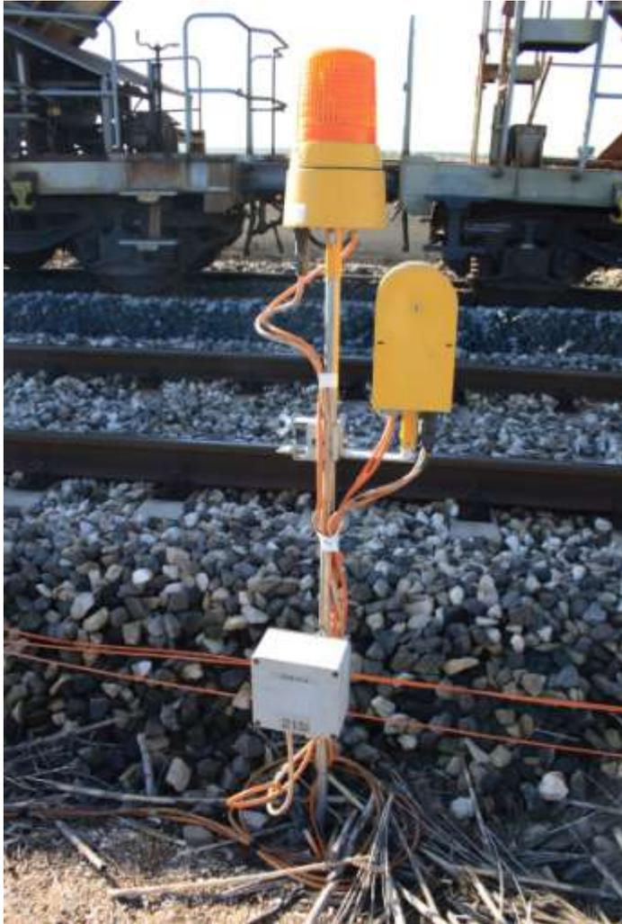
I pedali elettromeccanici e i sistemi di avviso sono collegati via cavo
