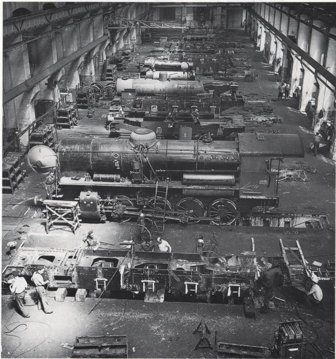
*Il reparto montaggio negli anni delle lavorazioni del "vapore". Si vede il carro modificato per una locomotiva Gr. 741.*
