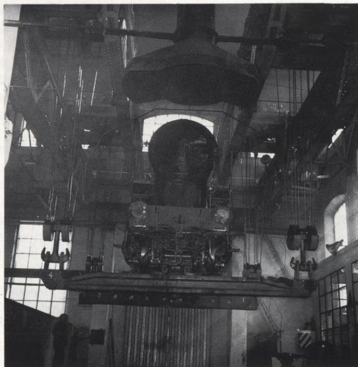
*Locomotiva Gr. 741 pronta per la prova a caldo. 1958.*
