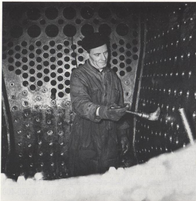
*Preparazione per la maschiatura dei fori dei tiranti del forno di una locomotiva Gr. 740/741. Archivio FS*
