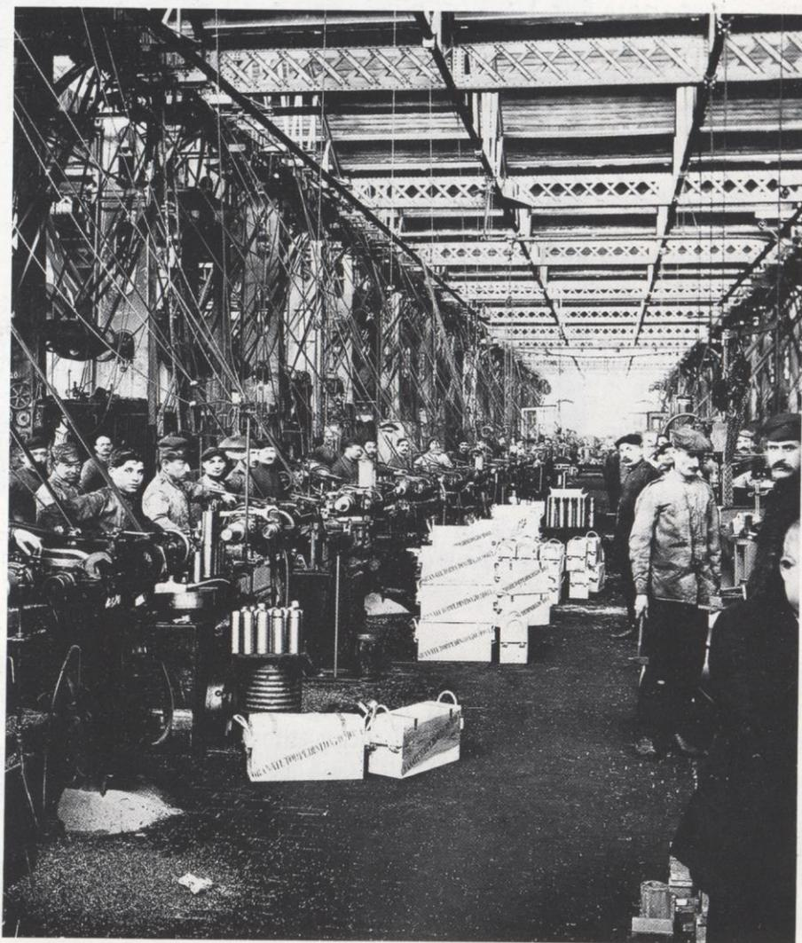
*Un'immagine dell'Officina durante la guerra 1915-1918: i torni prendevano il moto a mezzo di trasmissioni a cinghie, con puleggia motrice calettata su linee di trasmissione aeree, affrancate alle pilastrature visibili sul lato sinistro della fotografia.*
