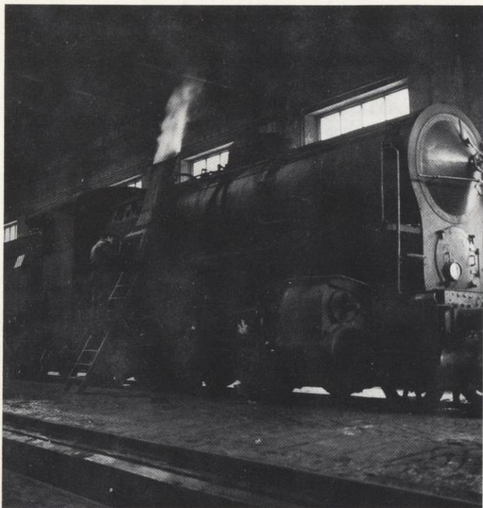
*Locomotiva Gr. 741, derivante dalla trasformazione delle locomotive Gr. 740. Ultime prove a caldo del preriscaldatore Franco-Crosti. 1958.*
