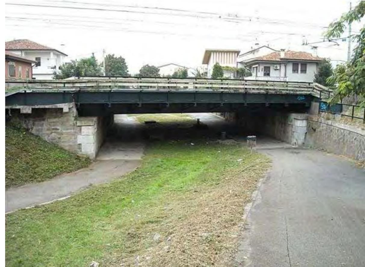
È stato dunque realizzato un **passaggio ciclopedonale**, che non risulta regolamentare, poiché la distanza fra il piano delle piste ciclabili e l'intradosso delle travi è di circa 2m.
