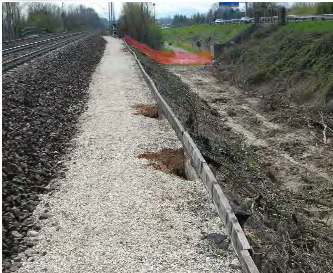
Cedimento del sostegno del sentiero con formazione di pericolose buche
