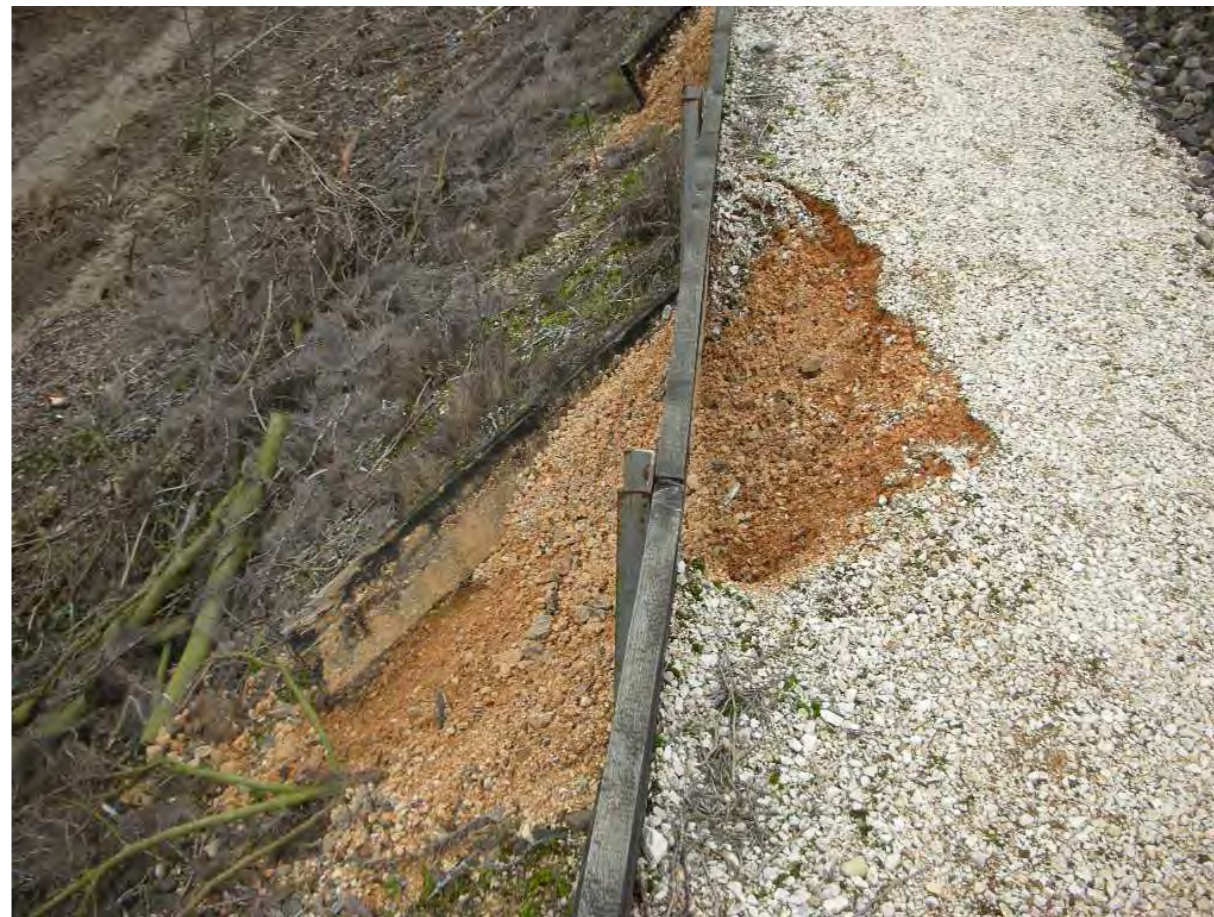
Cedimento del sostegno del sentiero con formazione di pericolose buche
