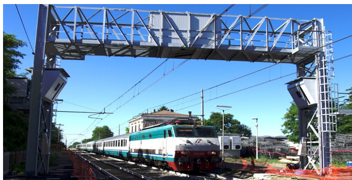
Carbonara – PMF monodirezionale su linea a doppio binario
