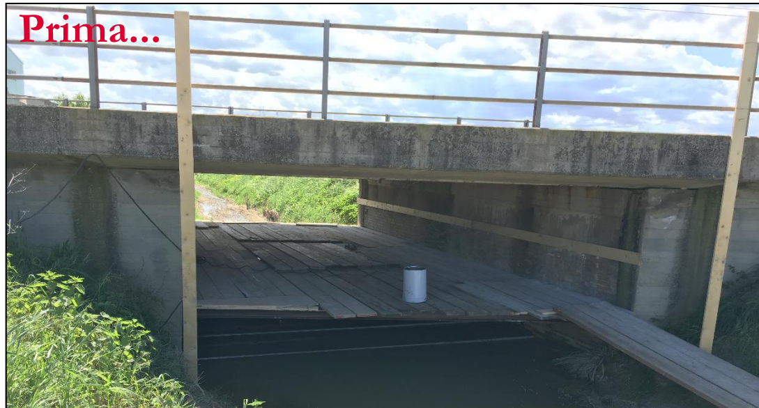
Ponte a travi incorporate "Bevano" km 74+588
