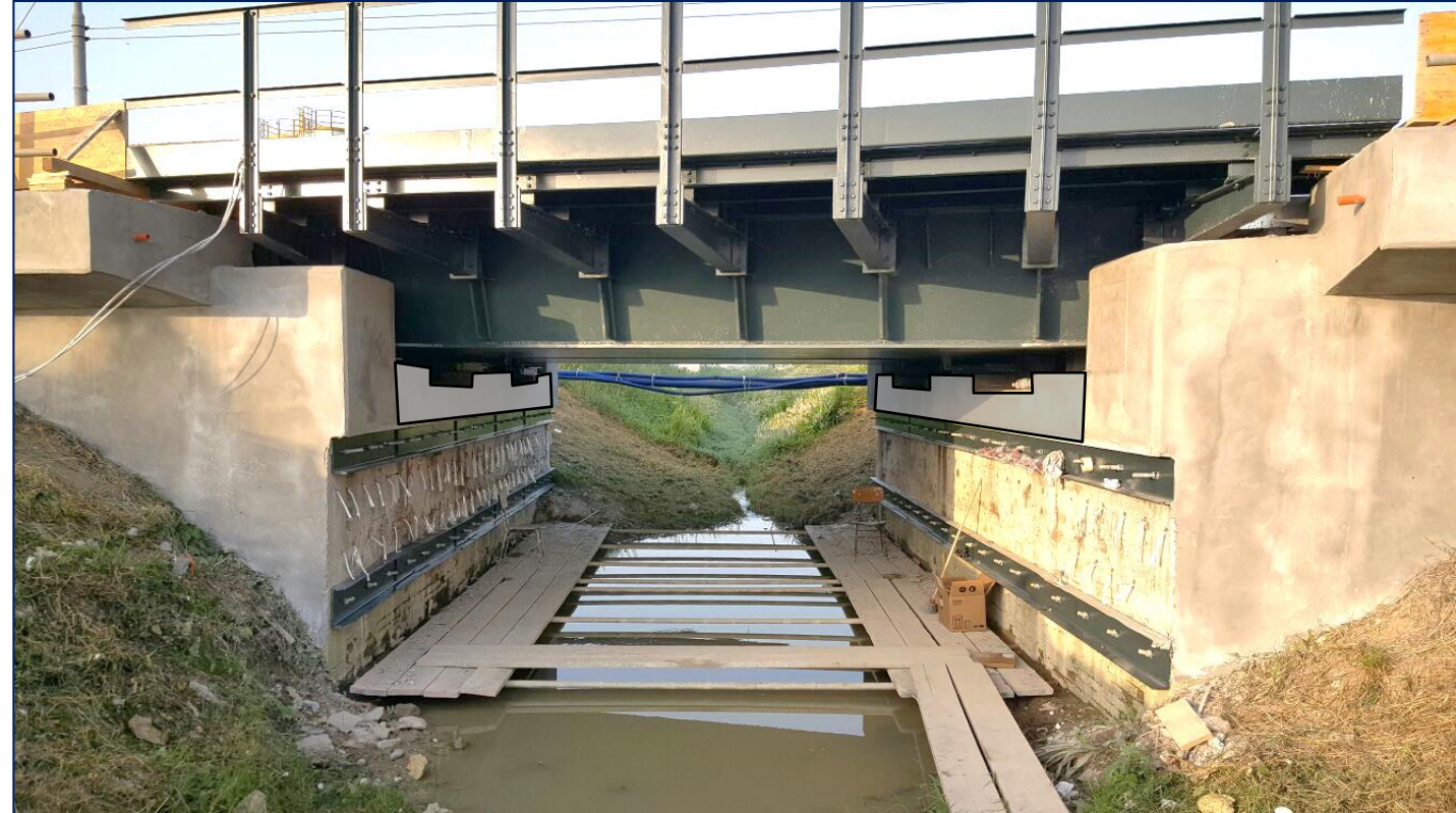
Ultimazione lavori con il consolidamento delle spalle
