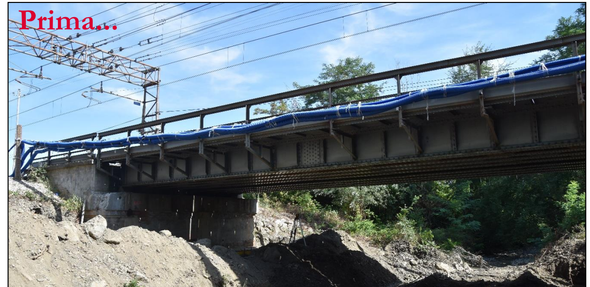
Ponte a travi gemelle "Quaderna" km 15+047
