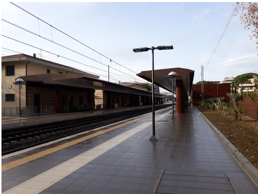
Costruzione di due pensiline di stazione in acciaio e riqualificazione dei corpi scala preesistenti
