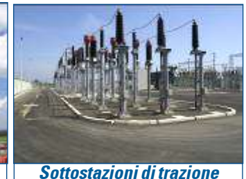
Sottostazioni di trazione
