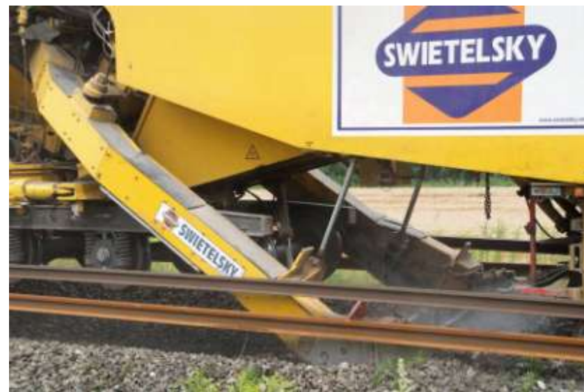
Scavo pietrisco e catena di livellamento
